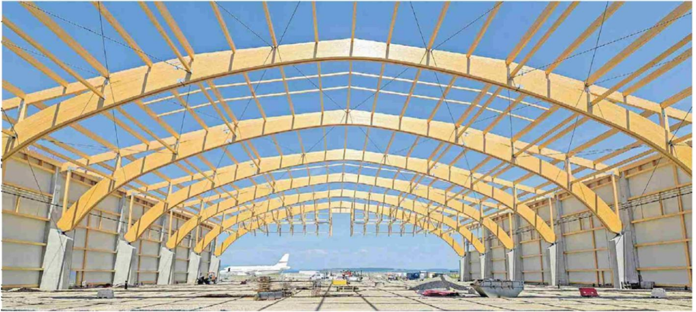
Ungewöhnliche Holzkonstruktion: der neue Hangar der Amac Aerospace auf dem Euro-Airport.
