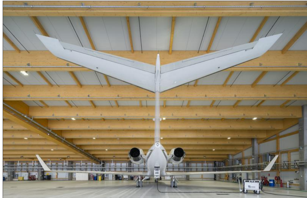
Le dernier hangar d'Amac Aerospace vient tout juste d'entrer en service. Vaste de 8500 m 2 avec une couverture en bois d'un seul tenant, long de 120 m, il a coûté 15M de francs suisses et peut accueillir entre 4 et 8 avions de taille moyenne. Photo DR
