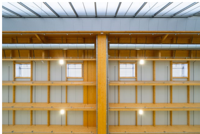
□ 屋顶天窗为机库提供自然光照。
